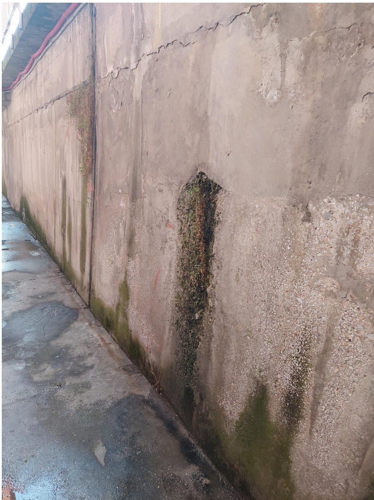
Prilog 6: Zid prema novom objektu, 17.11.2022.
